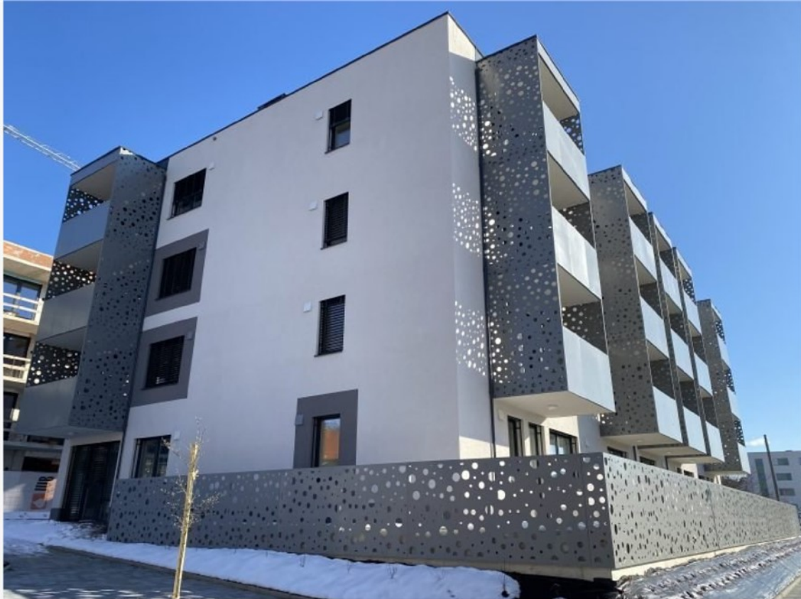
Najemna stanovanja v Slovenj Gradcu | FOTO: Stanovanjski sklad RS
