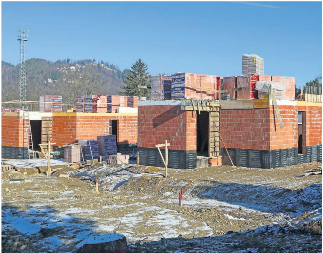
Sončne rezidence Vivendi so novo naselje v Bistrici ob Dravi. Vse enote bodo dokončane do tretje podaljšane gradbene faze. Foto: Sašo Bizjak
