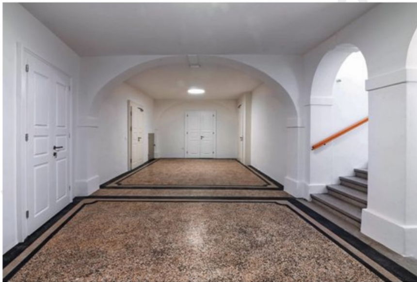
V stavbi se ni ohranilo veliko historičnih elementov, ena od izjem je teraco tlak.
