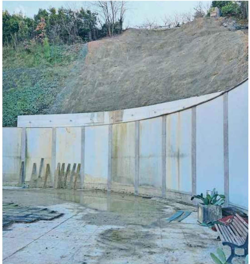
Višji zid naj bi zadržal zemljinu, ki bi morebiti še splazila z brežine.
