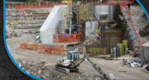
Gradbišče MHE Borovlje
