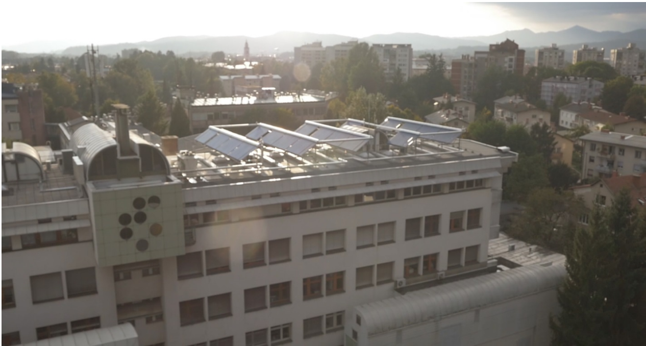
Slika 4: Pogled na kolektorsko polje, nameščeno na strehi stavbe C na IJS v Ljubljani
