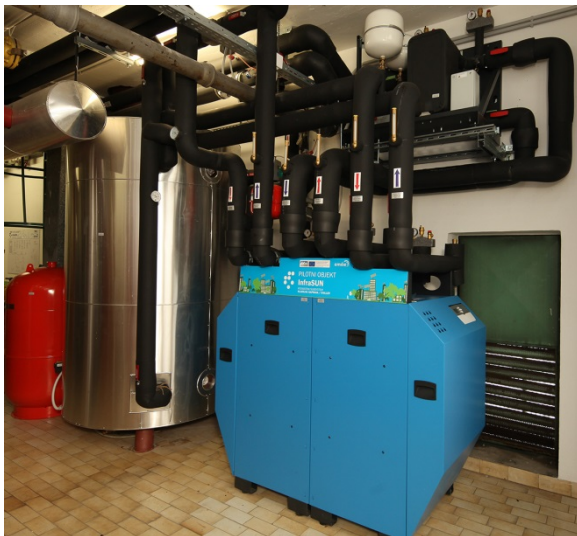
Slika 2: Hladilna naprava in zalogovnik toplote v strojnici stavbe C
