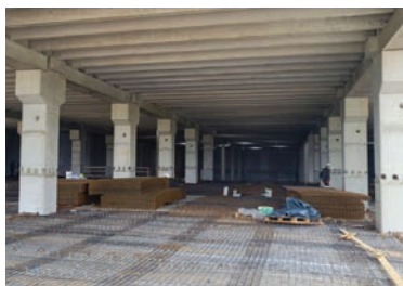
DR. KLEMEN REJEC, MATEJ PELJHAN Hibridna betonska gradnja v podjetju Kolektor Construction ■ Več na strani 7
