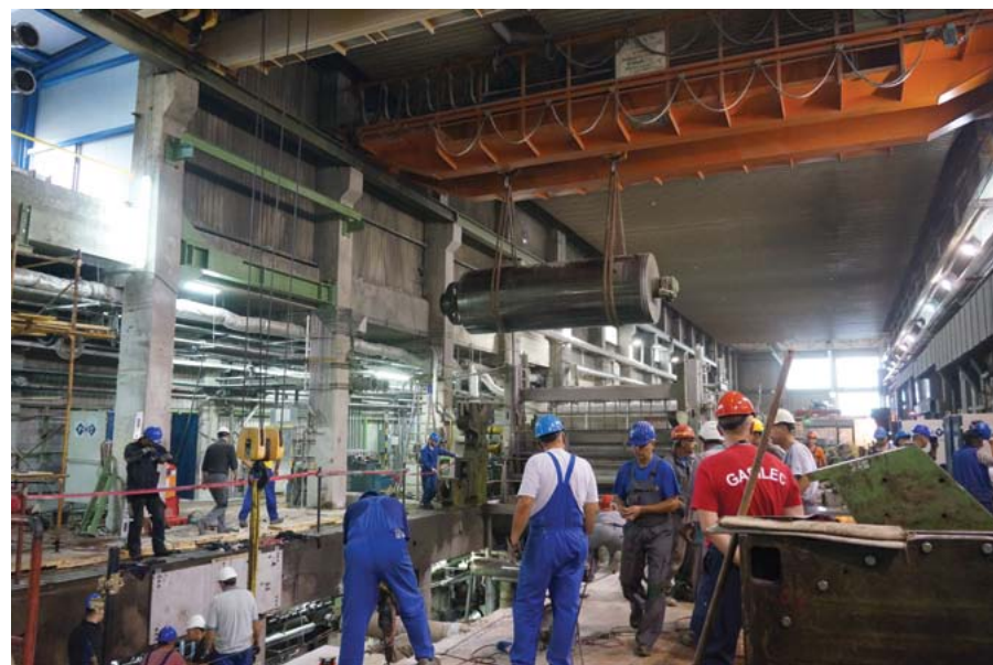
Spuščanje valjev Lowering the rolls
