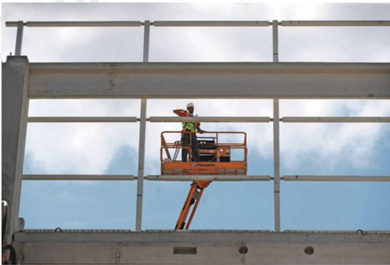
Javni naročniki so ključni za gradbeno panogo, saj ta za gradbeni sektor opravi 80 odstotkov vseh del, medtem ko je evropsko povprečje pri 31 odstotkih. FOTO LEON VIDIC
