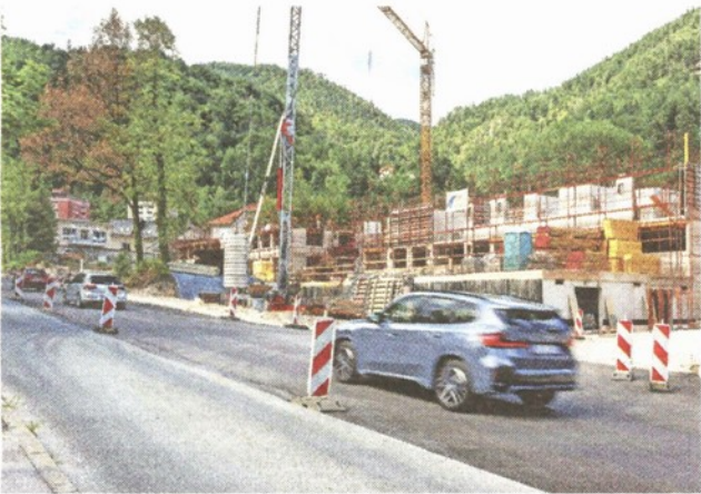
Cesta je ponovno odprta, hitro pa napreduje tudi gradnja dveh večstanovanjskih objektov ob njej. / Foto: Nik Bertoncelj
