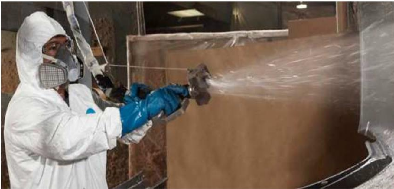
Posnetek laminacije s pištolo na sekance.
