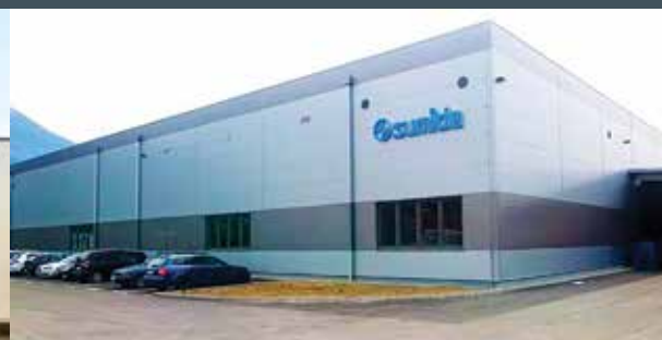
Poslovno-proizvodni objekt Sumida na Blejski Dobravi, 2015
