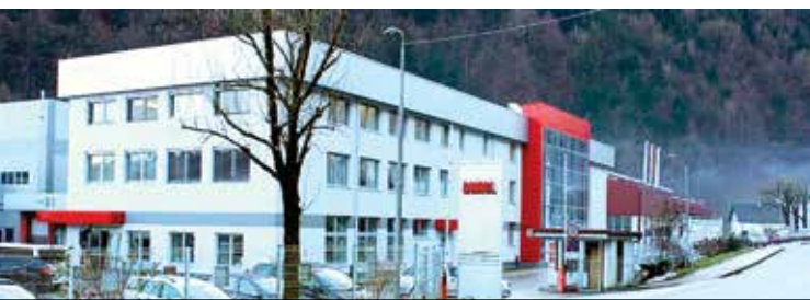
Rekonstrukcija poslovne stavbe Domel v Železnikih, 2015
