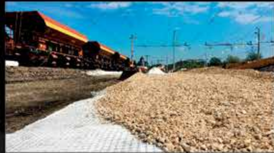
armiranje slabonosilnih tal - železnice
