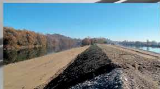
protierozijska zaščita nasipov - Drava
