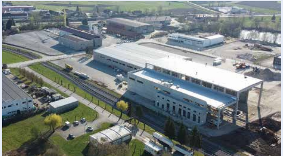
Tovarna TPV v IPC Brežina med gradnjo
