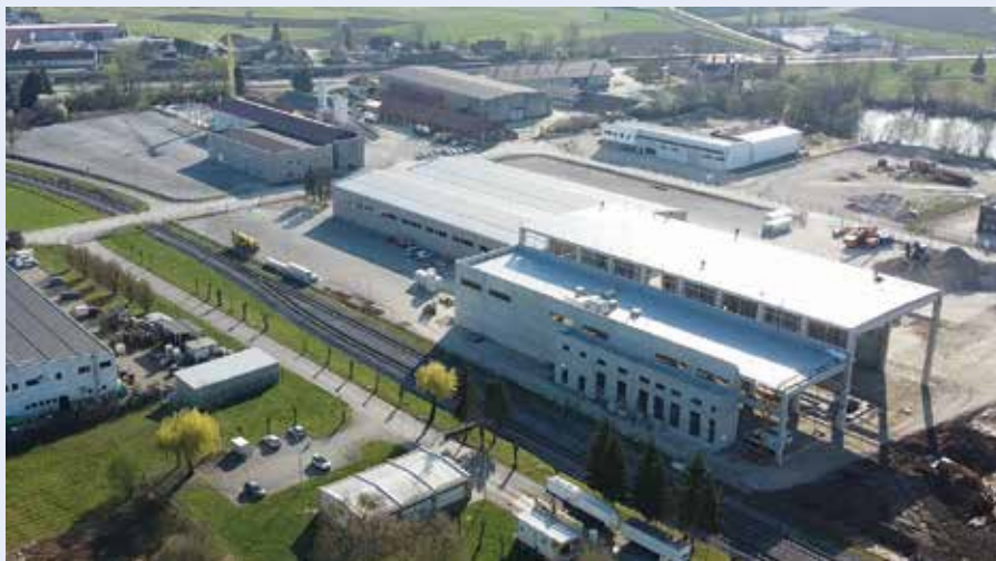
Tovarna TPV v IPC Brežina med gradnjo
