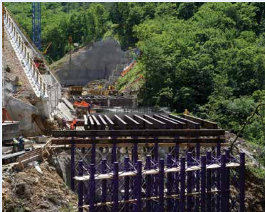
Gradnja premostitvenega objekta v dolini Glinščice.
