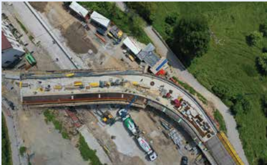
Obnova nadvoza čez železniško progo Radovljica
