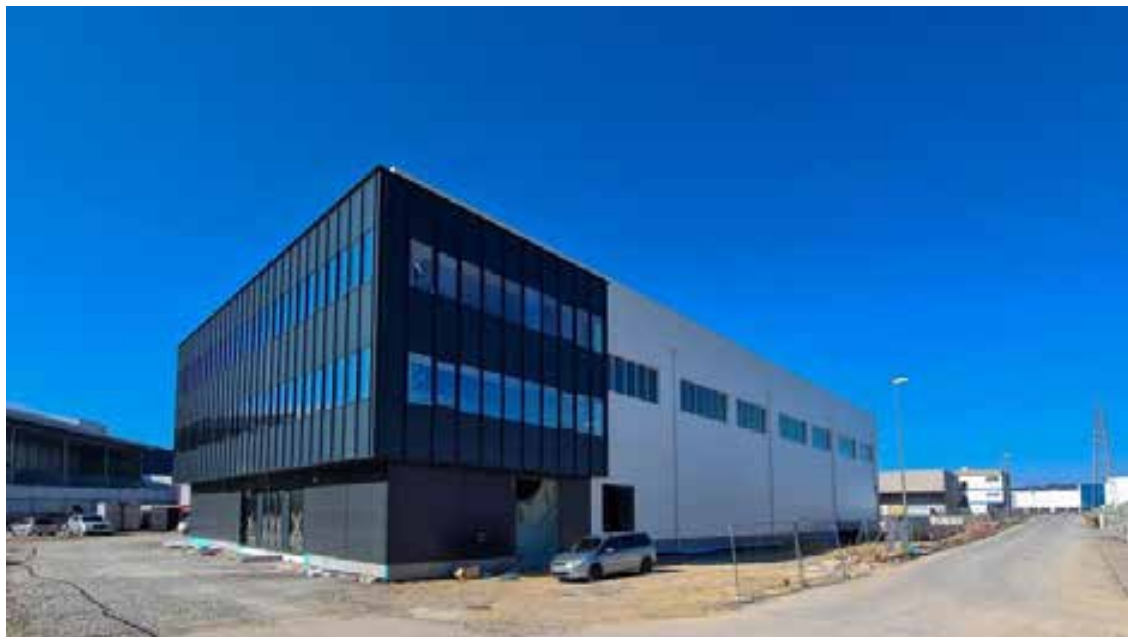
Gradnja novega Požarnega laboratorija ZAG v industrijski coni v Logatcu
