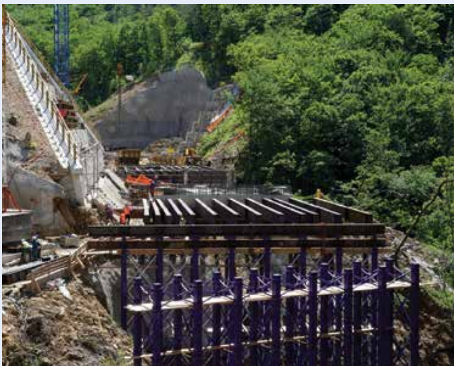
Gradnja premostitvenega objekta v dolini Glinščice.
