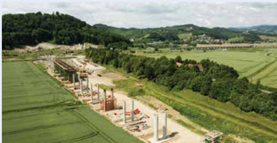
Pogled na gradbišče Maribor – Šentilj. Fotografija posneta v juniju 2021.
