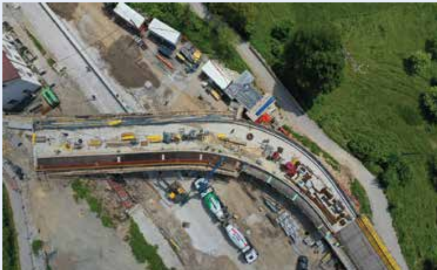
Obnova nadvoza čez železniško progo Radovljica
