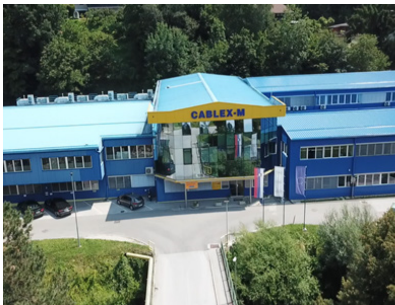
Foto: Arhiv Cablex
