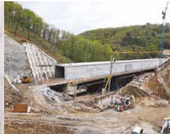
Viadukt Glinščica 2. tir - 2TDK
