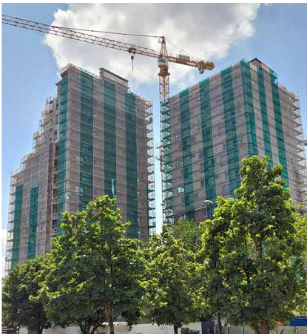
Gradnja nove stanovanjske soseske na Litostrojski cesti
