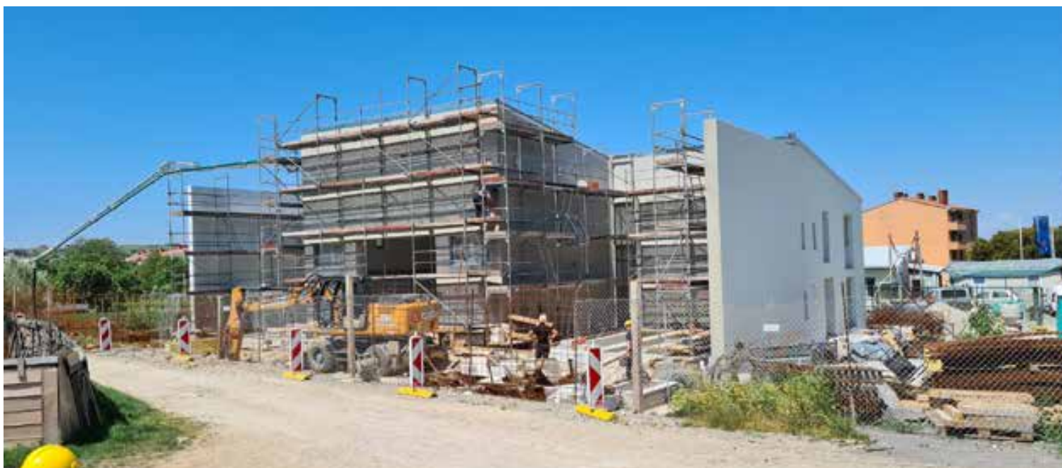
Elektro Primorska RTP Izola
