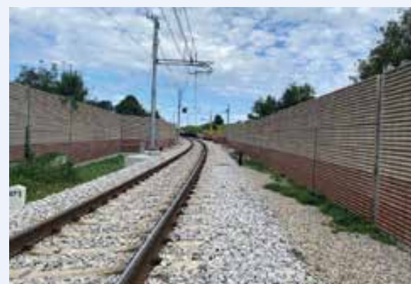
PHONOBLOC® protihrupni paneli serije BHB (betonsko nosilno jedro in lesobetonski / lesocementni absorberji). Naročnik RS Ministrstvo za infrastrukturo, DRSI. Objekt Izvedba protihrupne zaščite na odseku železniške proge Šentilj Pesnica. Izvedeno okrog 20.000m2 protihrupnih panelov v dolžini 9km.
