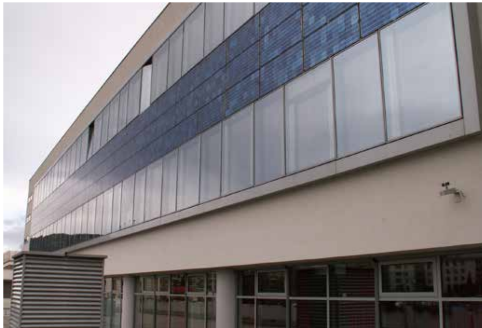
Fotovoltaični paneli integrirani v fasado.
