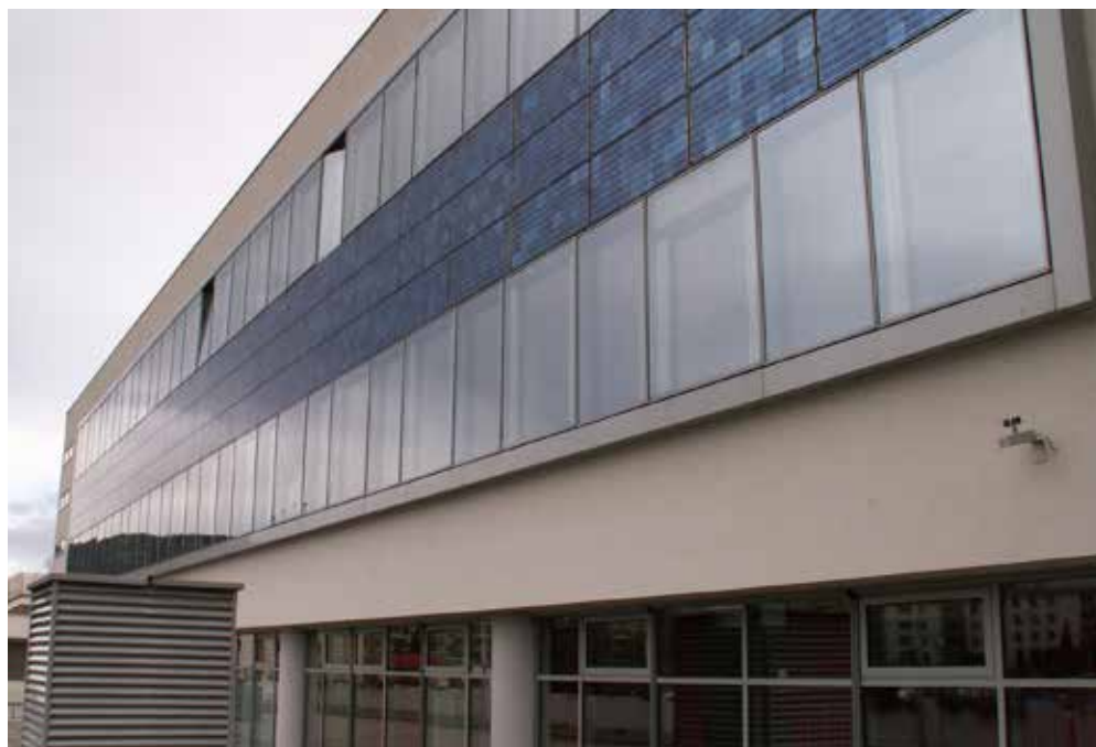
Fotovoltaični paneli integrirani v fasado.
