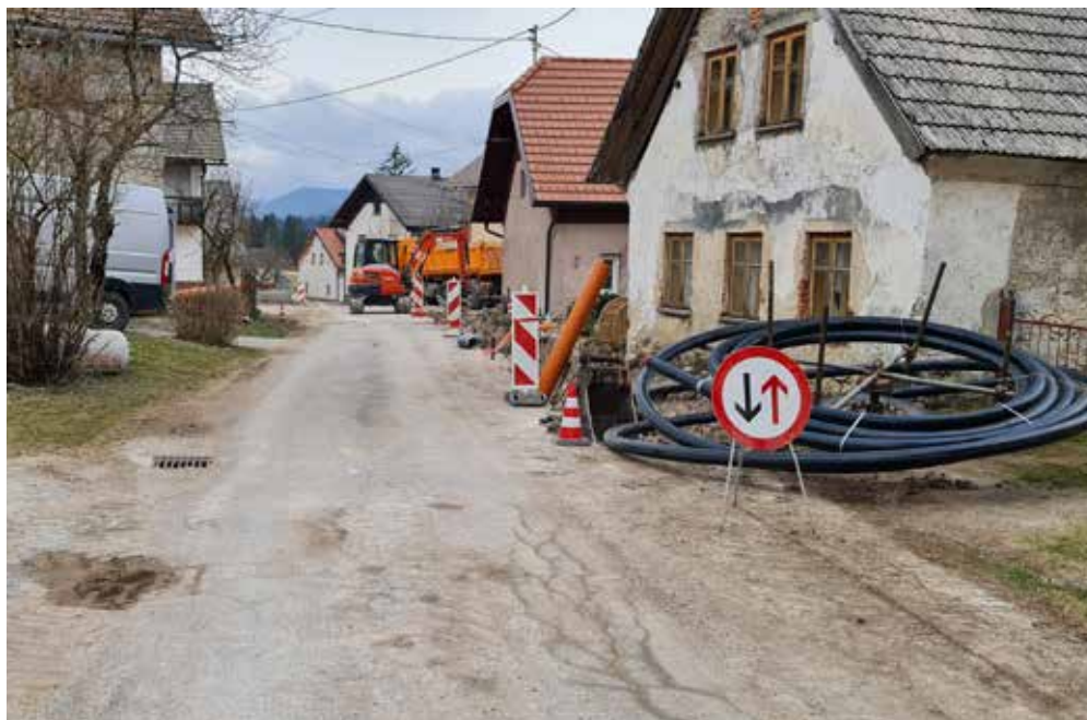
Gradnja okoljske infrastrukture v naselju Ulaka v občini Bloke.
