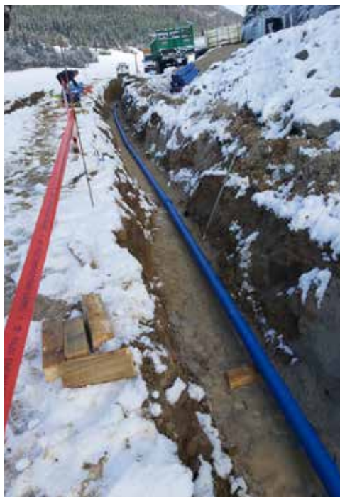
V občini Loška dolina obnavljajo primarne vodovode.
