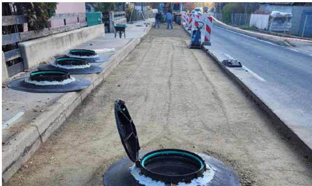
Zaključna dela na cesti Maribor-Ruše v Laznici.
