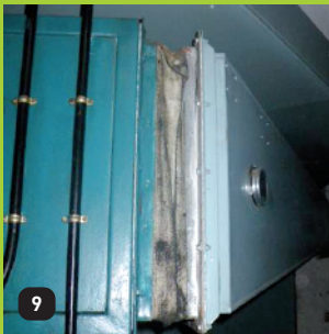
Protipožarna, toplotna in hladilna izolacija za cevovode
