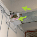
Cementno vezana izolacija sestavnih delov in inštalacij
