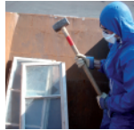
Odstranjevanje okenskih stekel s kladivom (zunaj)
