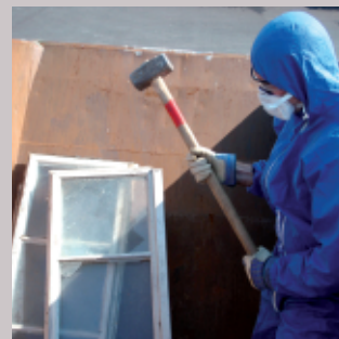
Odstranjevanje okenskih stekel s kladivom (zunaj)
