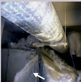
Cementno vezana izolacija
