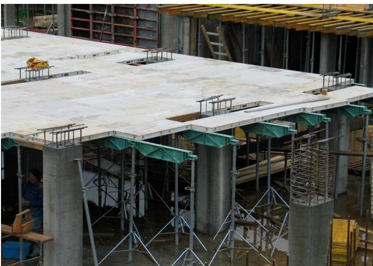
Stropni opazni sistem sestavljajo trije elementi: podpornik, ECO SPEED nosilec, EPIC ECO kasetni element.
